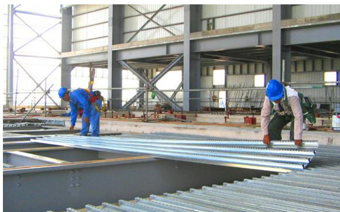
Figura 1.6 - Colocação das chapas perfiladas de aço em obra.
