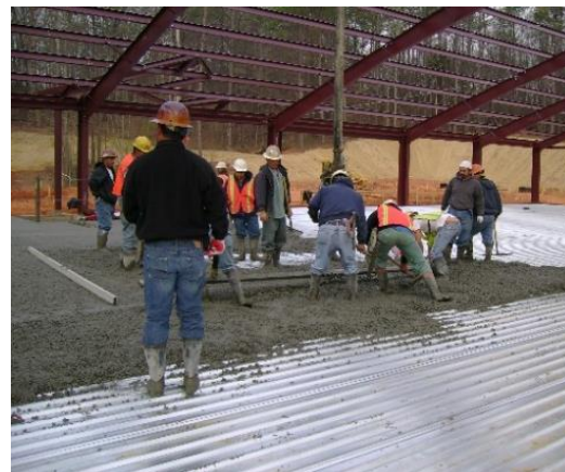
Figura 1.4 - Betonagem de uma laje mista.
