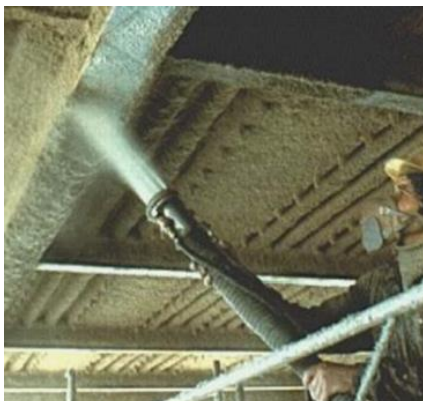
Figura 1.11 - Aplicação do spray cimentício.
