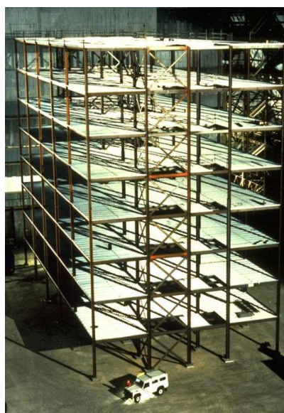
Figura 2.17 - Edifício em construção mista antes da betonagem das lajes.
