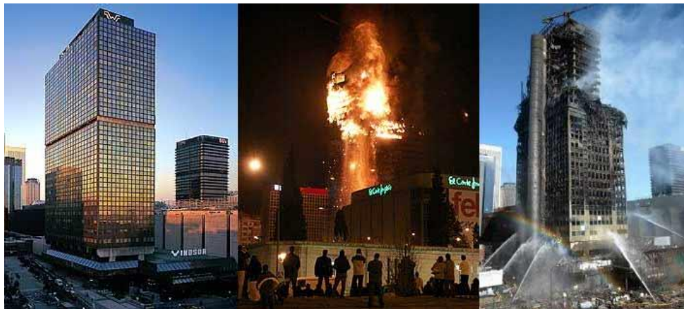
Figura 2.15 - Torre Windsor, antes, durante e após o incêndio.
