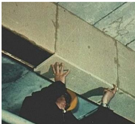
Figura 1.12 - Colocação em obra das placas de material isolante.
